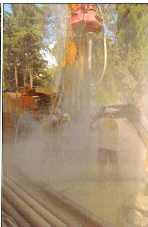
Photographie 2 : Foration au marteau
