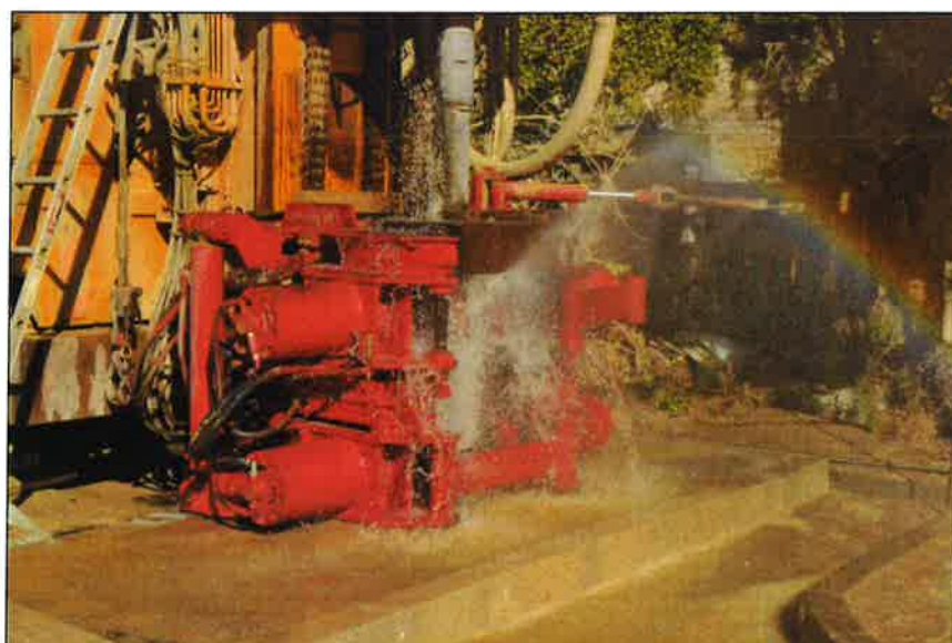
Photographie 3 : foration au droit des fractures productrices
