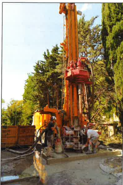
Photographie 1 : Foration au rotary
